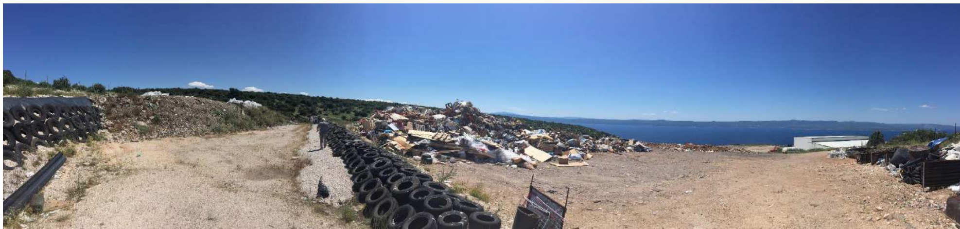
Slika 2.2.-5. Pogled na kazetu za građevinski otpad koji sadrži čvrsto vezani azbest s vidljivom gomilom glomaznog otpada.
